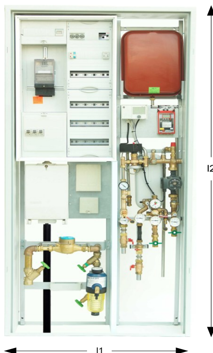
Abbildung 5 – Darstellung einer Hausanschlussnische
